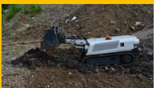
Figura 4: operazioni di carico e scarico della benna
