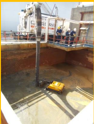
Figura 3: Lavoro in spazi confinati in combinazione con l'escavatore a rischio
